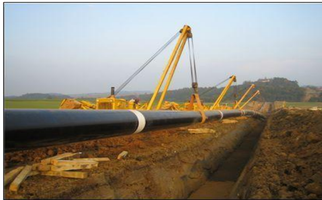
Εικόνα 1: Τοποθέτηση αγωγού ΥΠ
