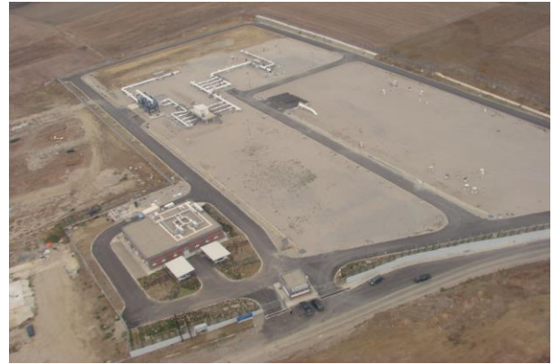
Εικόνα 3: Μεθοριακός Σταθμός Κήπων: Μέτρηση και Ρύθμιση ροής
