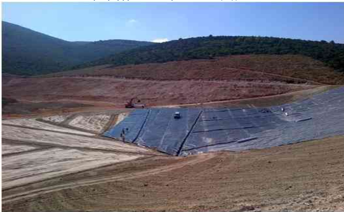
Εικόνα 8.3: Στεγανοποίηση χώρου απόθεσης μεταλλουργικής σκωρίας με χρήση αργίλου και γεωμεμβρανών σε εγκαταστάσεις της ΛΑΡΚΟ
